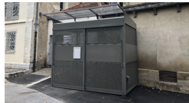
Parking vélo sécurisé à la gare de Bayonne
